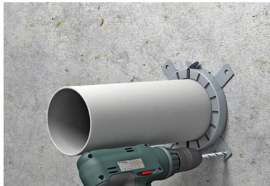
\* Abweichend davon dürfen bei Durchführungen von Rohren der Rohrgruppe A1, A7, B1, B7, C und G Rohrmanschetten bis zu einem Innendurchmesser von 164 mm an Rohren angeordnet werden, die bis zu drei Abmessungsstufen kleiner sind, als das zugeordnete Rohr.
