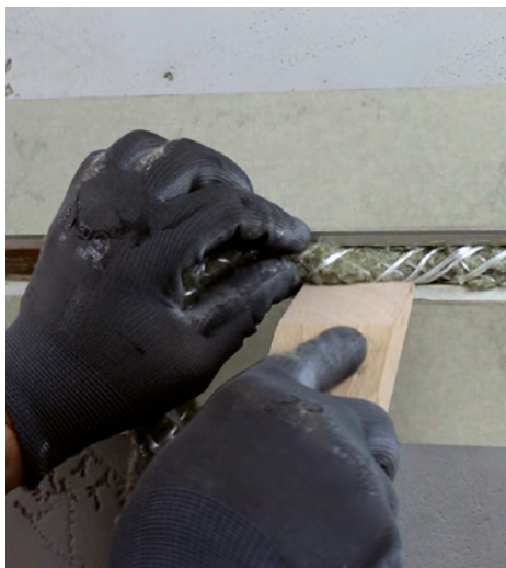
Nullifire FJ203 in Fuge einbringen
